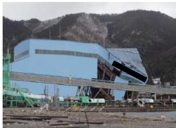
図2 船舶衝突により崩壊した上屋<sup>3)</sup>
